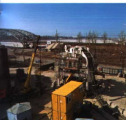
Эксплуатация VSM 7700 на строительной площадке в Санкт-Петербурге.
